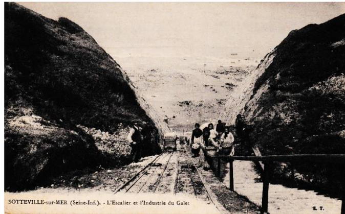
Afin d'actionner les wagonnets —l'un monte pendant que l'autre descend- il y avait un cheval (ou un mulet) placé en haut des marches qui, tirant une corde, faisait monter ou descendre un wagonnet, en avançant ou reculant, assurant ainsi la traction de la charge.
